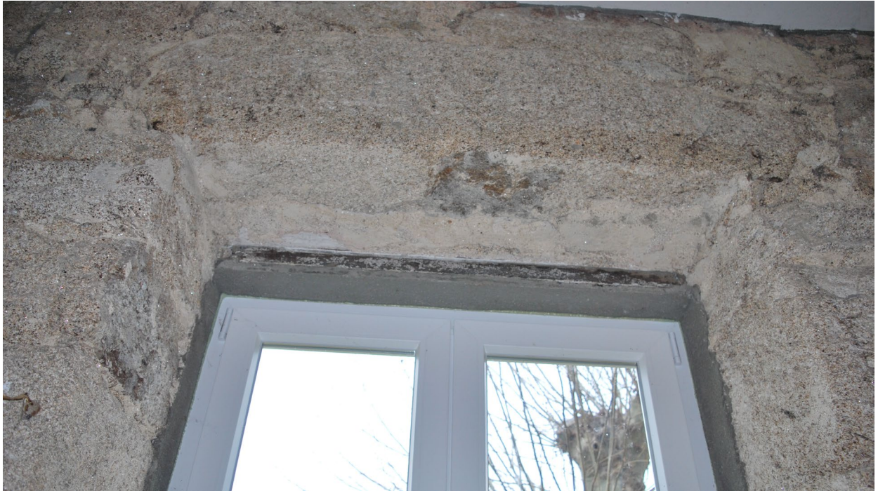
Dintel ventanas sala principal
